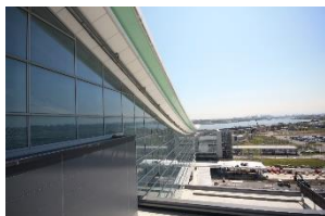
軒天パネル施工例
