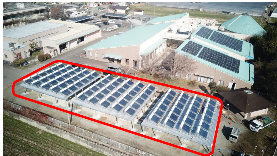
▲カーポート型架台&太陽熱集熱器84台 (写真赤囲みの部分)
