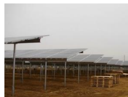
太陽電池アレイ支持架台設置工事
