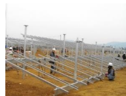
太陽電池アレイ支持架台設置工事
