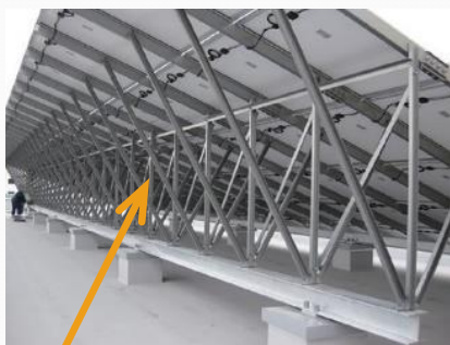
① 太陽電池アレイ支持架台
