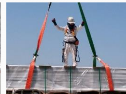
耐火/不燃断熱パネル設置工事
