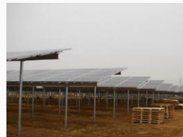
太陽電池アレイ支持架台設置工事
