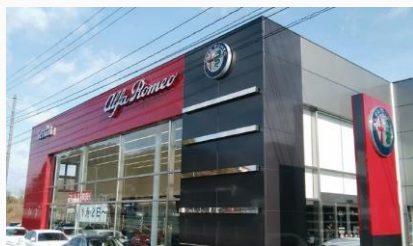
⑦ 外壁パネル (アルファロメオ店舗)
