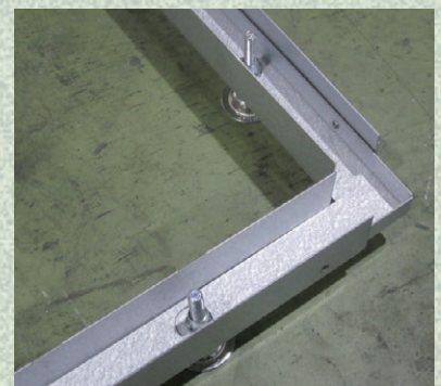
コーナー金具により施工が簡単
